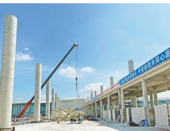
白雲機場三期擴建工程西四指廊施工現場。廣東省機場集團供圖
