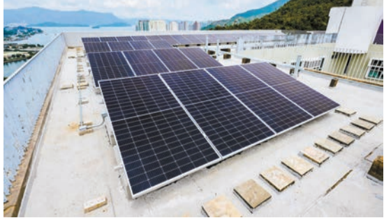
「減碳恒動—太陽能關懷計劃」首個太陽能系統工程在突破青年村順利落成，共安裝268塊太陽能板，預計每年可產生15萬度電力，有助減少碳排放。
