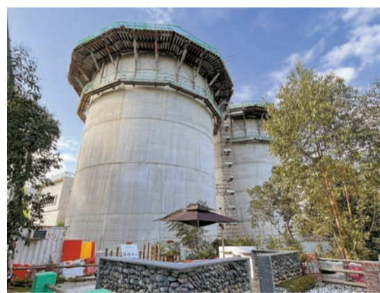
壓氣消化缸是香港有機資源回收中心第二期的心臟，把廚餘轉化為沼氣，再燃燒沼氣發電。
