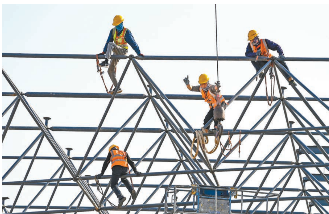
國家統計局昨日公布數據顯示，1-2月份，全國固定資產投資同比增長5.5%。圖為福建福州，工人在項目工地高空作業。中通社
