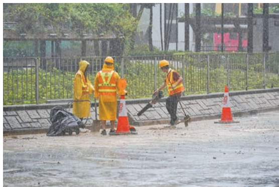
工人在環翠邨抽走積水。
