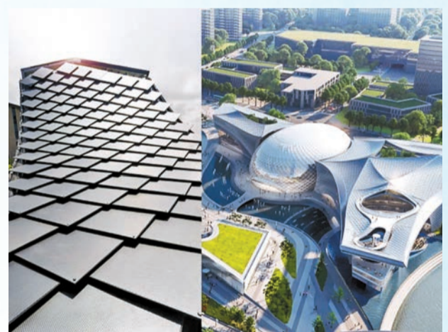
全球首個鈣鈦礦光伏工業園落子無錫。
