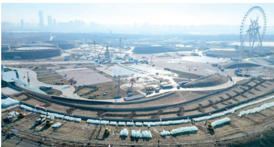
第二十七屆哈爾濱冰雪大世界冰建工程施工現場。新華社
