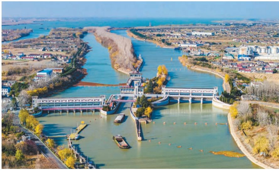
南水北調東線一期工程運鹽閘、邵仙套閘、邵仙閘洞。新華社
