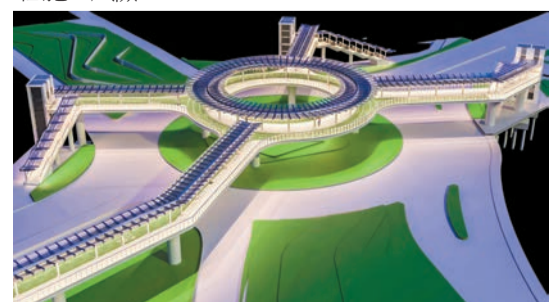
粉嶺繞道（東段）將於5月3日上午8時通車。其中，龍躍頭交匯處的單車徑行人天橋採用S960國產超高強鋼建造，是全球首座使用該級別鋼材的行人天橋。
