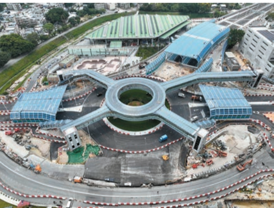
龍頭環交匯處環形行人天橋，是全球首條應用S960國產超高強度鋼材建造的行人天橋。甯漢豪網誌圖片
